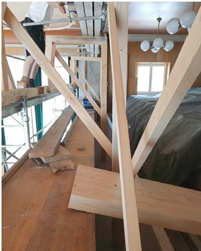
Der betroffene Dachbinder war durch den Wasserschaden und Holzschädlinge nicht mehr ausreichend tragfähig. Zur Sicherung des Binders musste unterhalb des Fachwerkuntergurts ein Unterzug eingebaut werden, der die Lasten aus dem Dach und dem Dachboden aufnimmt.
